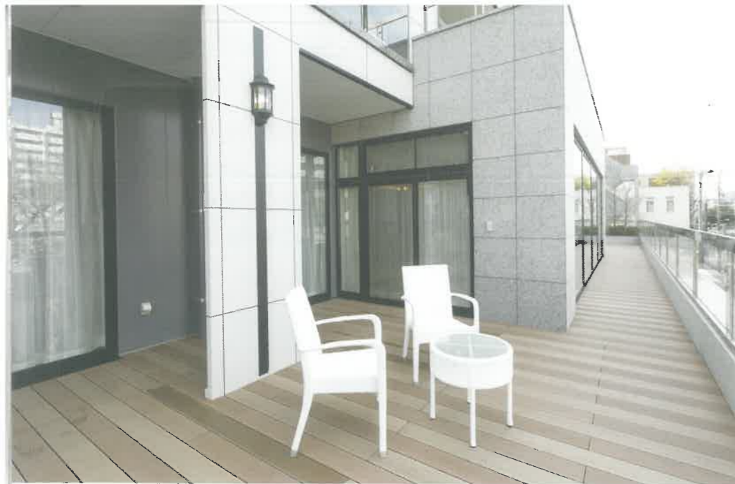
ウッドテラス
