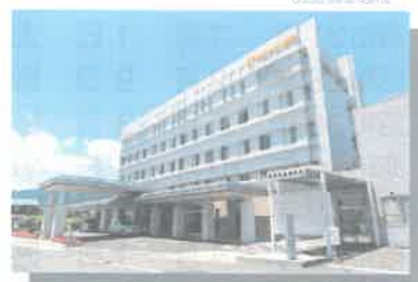
第5期新本館増築及び既存棟改修工事 平成 25 年 10 月 31 日 竣工
