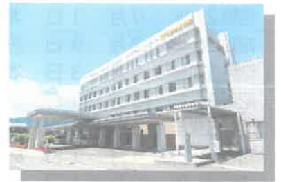
第 5 期新本館増築及び既存棟改修工事 平成 25 年 10 月 31 日 竣工
