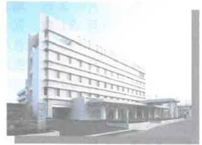
第5期新本館増築及び既存棟改修工事 竣工 25年10月31日
